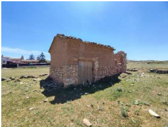
Caseta de era
