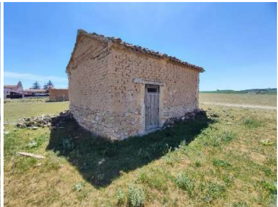
Caseta de era
